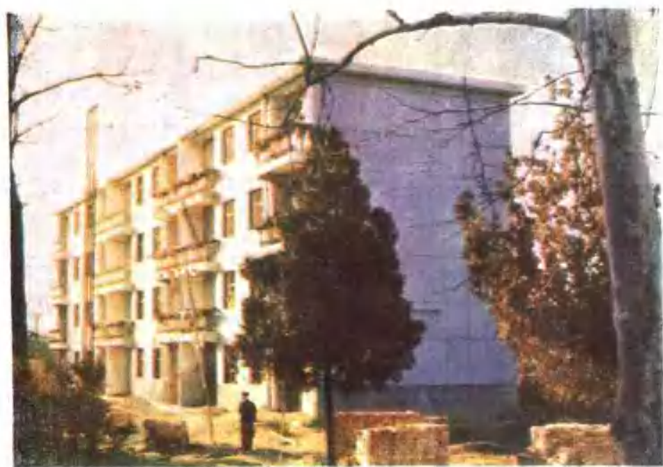
县人民医院正兴建的知识分子楼
