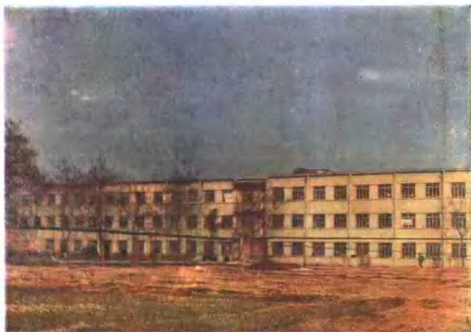
县 人 民 医 院 病 房 楼
