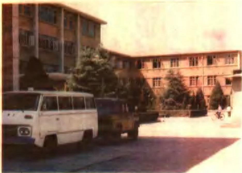
南 阳 地 区 人 民 医 院 门 诊 楼
