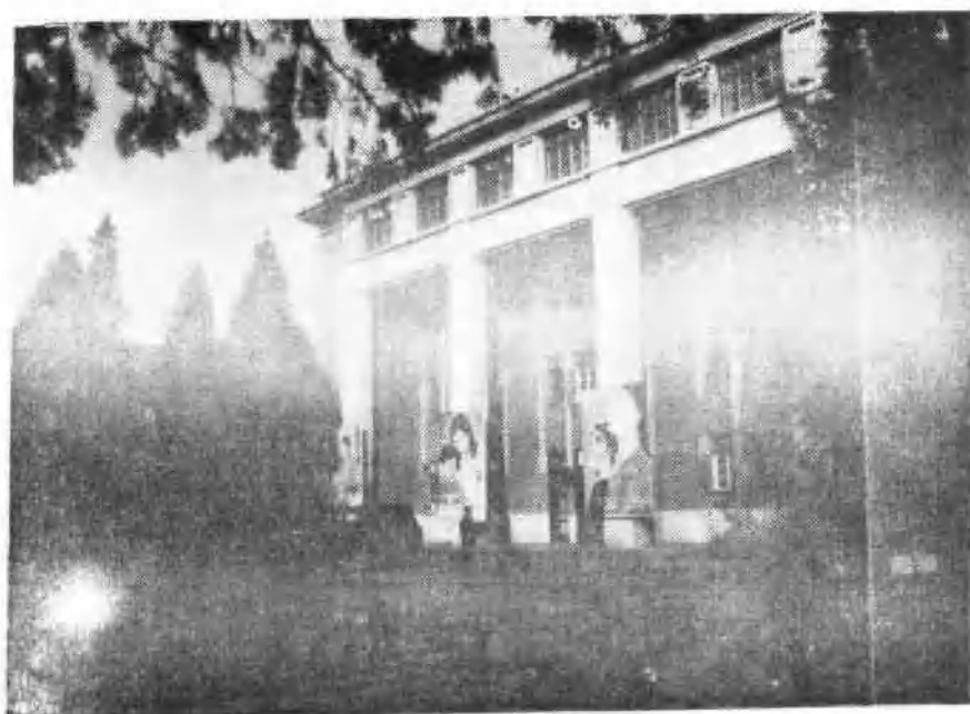
地区卫生局办公处（行署东楼三楼）
