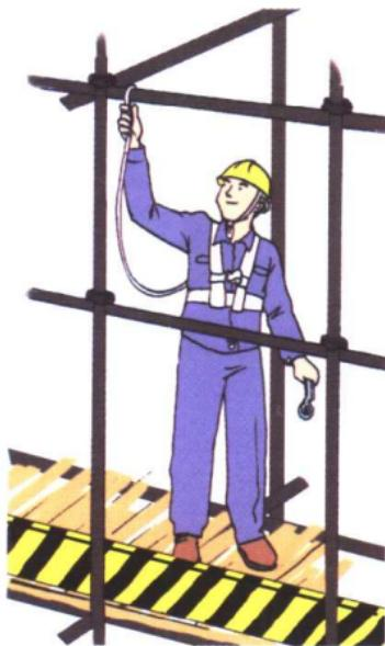
②在2米以上(含2米)有可能坠落的高处作业,必须系好安全带;安全带应高挂低用。
