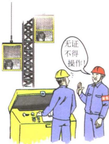
2. 垂直运输机械操作人员在作业过程中，应集中精力正确操作，注意机械状况，不得擅自离开工作岗位或将机械交给其他无证人员操作，严禁无关人员进入作业区或操作室内。
