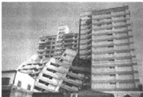
图 1-9 大地震中建筑物倒塌
