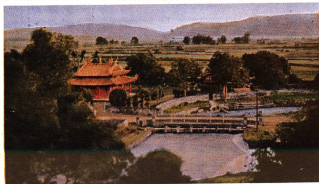
台灣開墾初期既無機械設備，也少有測量器具，全靠先民一鋤一斧地挖掘。彰化八堡圳則是清代台灣著名的水利工程之一。
