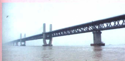
芜湖长江公铁路斜拉桥
