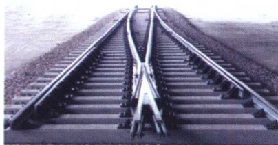
城市地铁轻轨道岔
