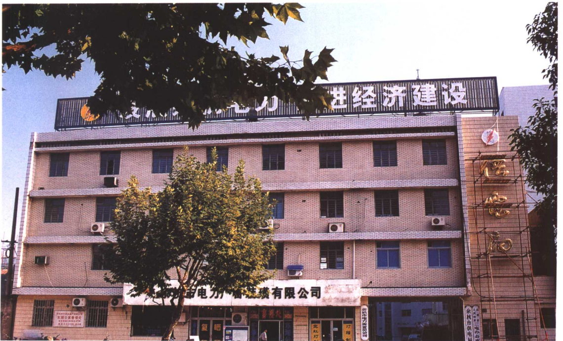
建于 1982 年的余杭供电局大楼
