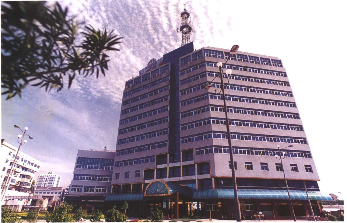
1996 年 12 月建成的余杭供电局大楼
