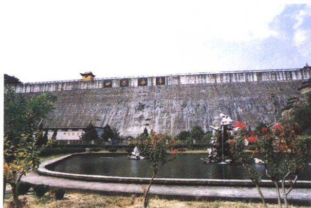
四岭水库电站
