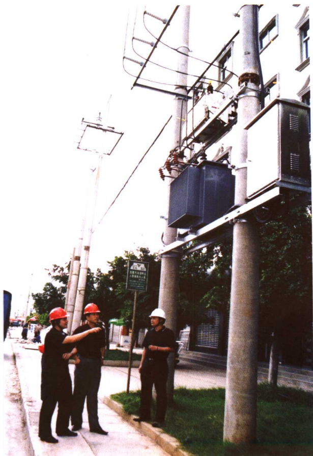
公司领导深入现场进行施工质量检查
