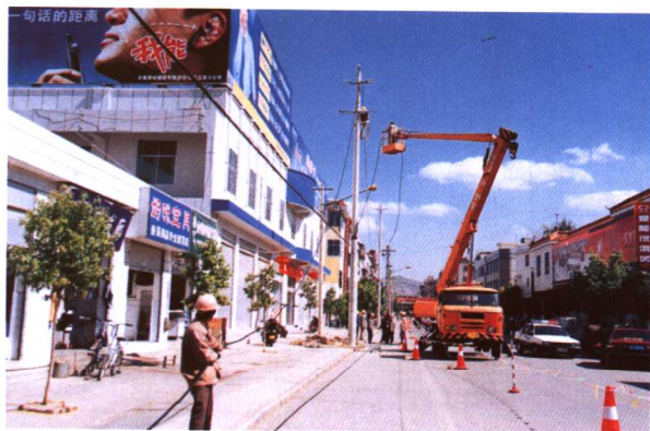
江川县城市电网改造施工现场
