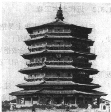
图 1-1 山西应县木塔
