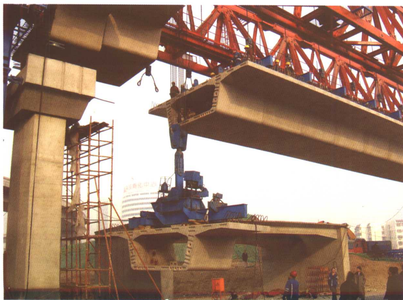
在石景山南站采用拼装技术施工的高架桥梁
