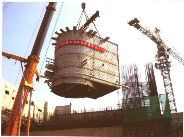
中国先进研究堆(CARR)堆本体设备的吊装现场
