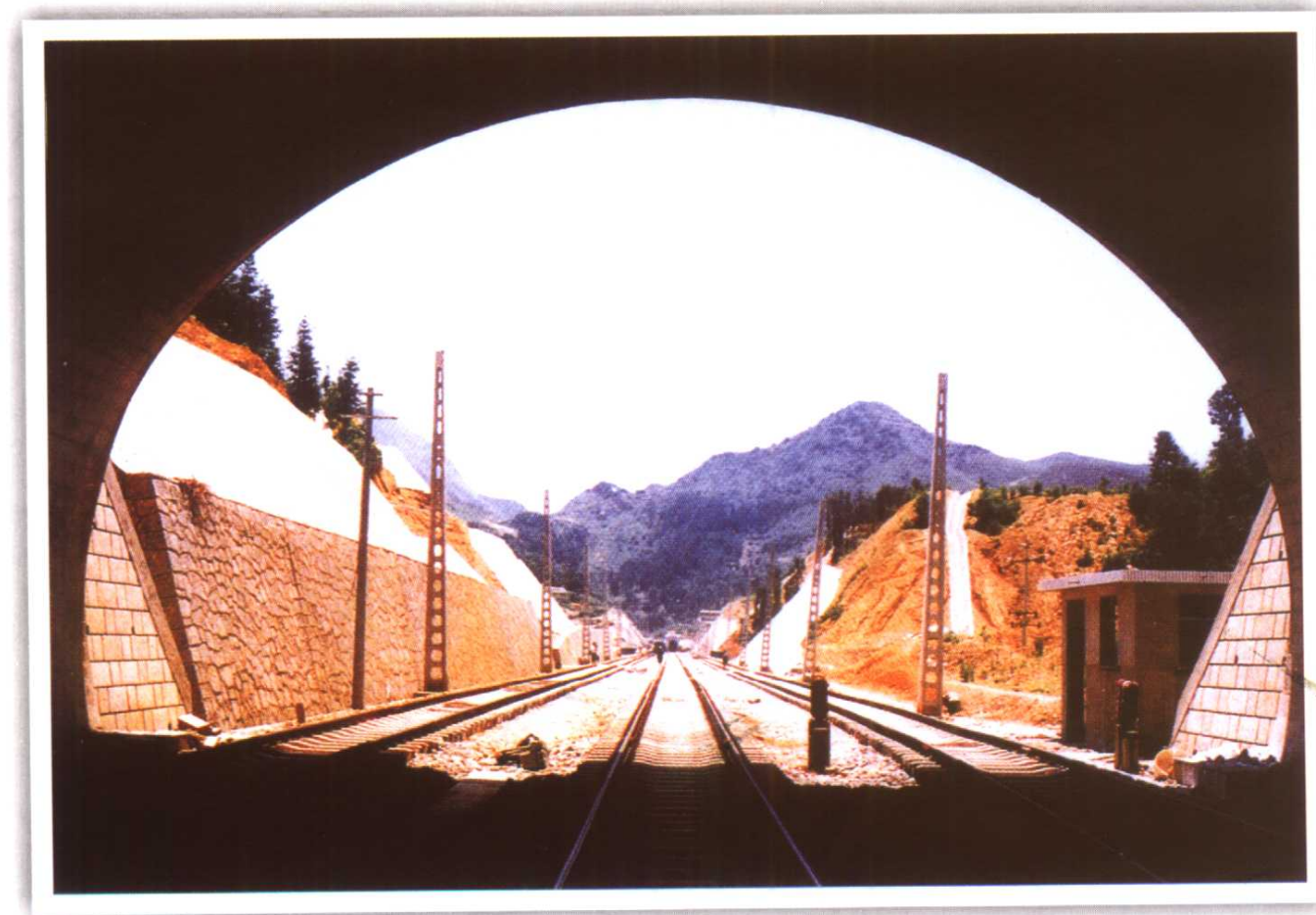
沙厂坪2号三线隧道
