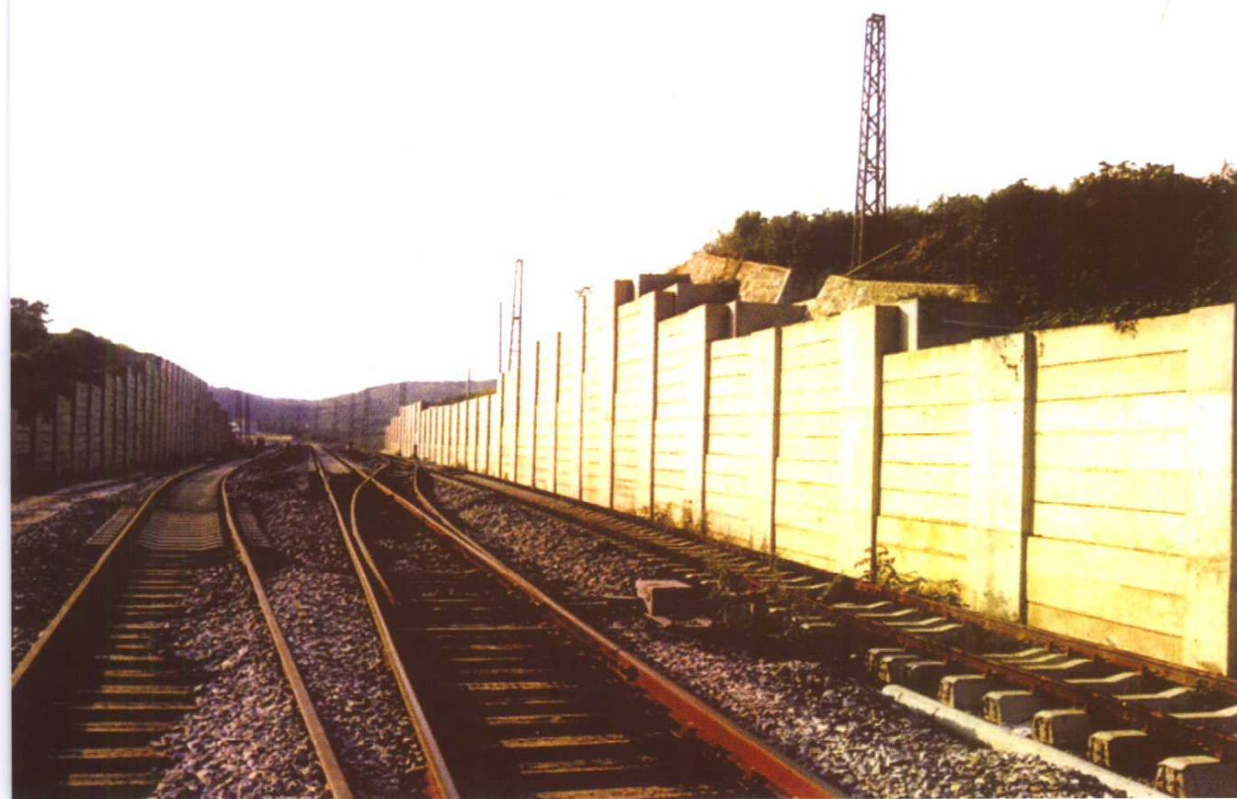
采用桩板式抗滑挡墙处理膨胀土
