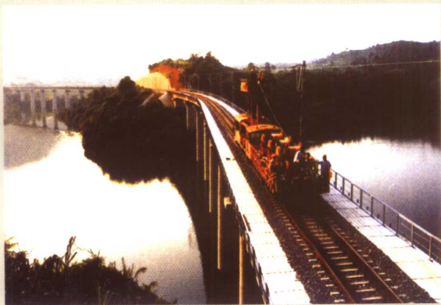
施工中的电气化工程
