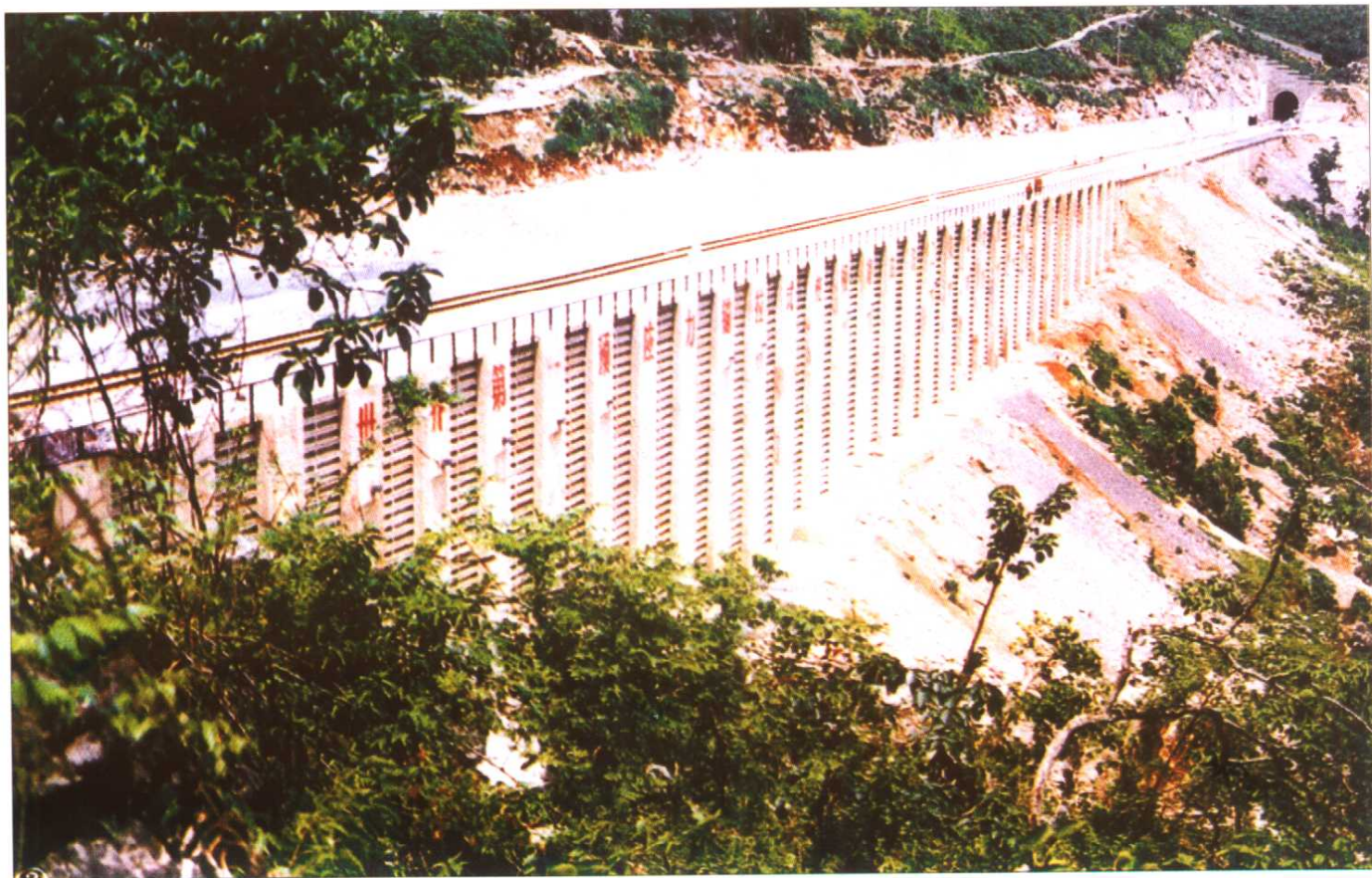
石头寨锚拉式桩板墙
