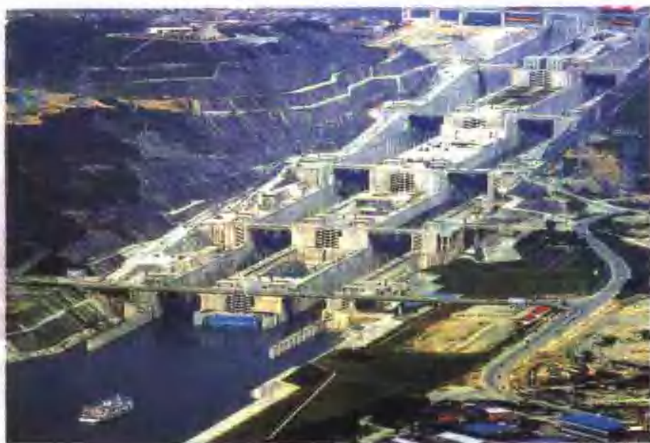
图 10—13 五级方式的三峡船闸
