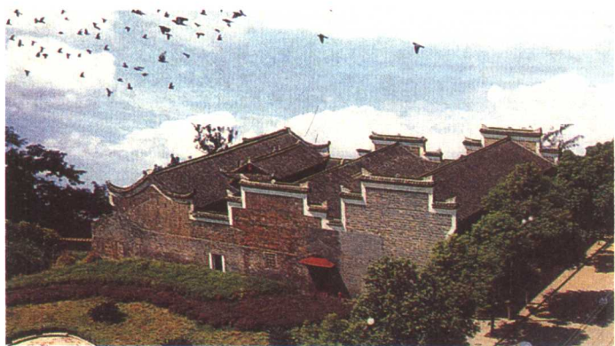
谭嗣同故居俯瞰
