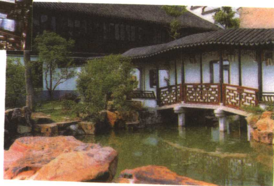
薛福成故居廊桥
