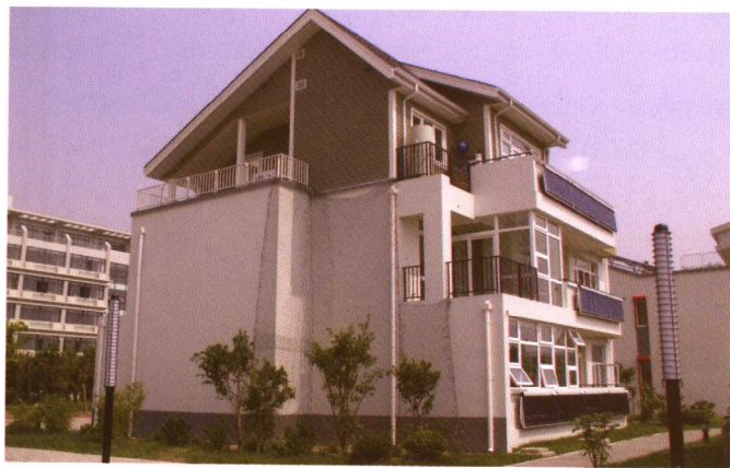
图 0-13 建成后的木结构加层
