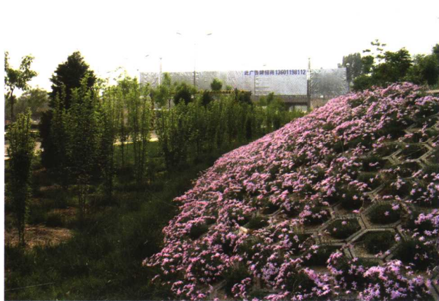
坡面混框格种植地被植物
