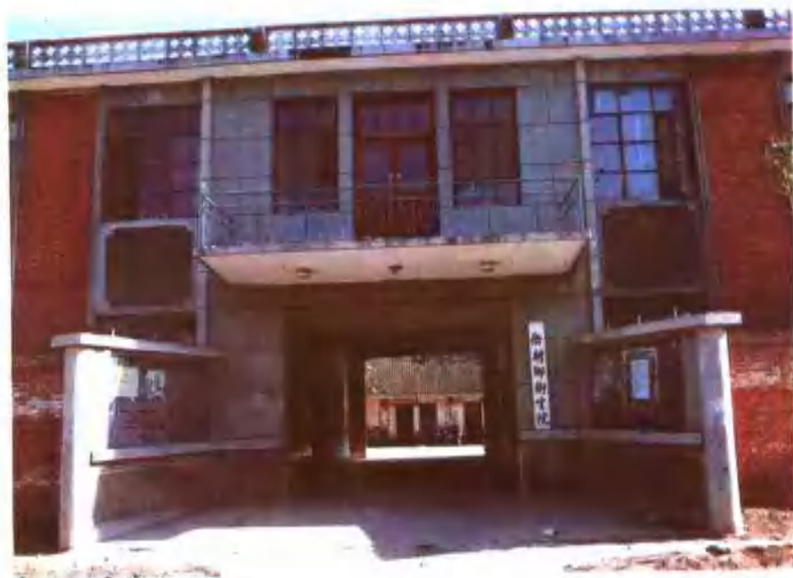
岳村乡卫生院门诊楼
