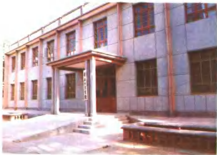
黄庄乡卫生院门诊楼
