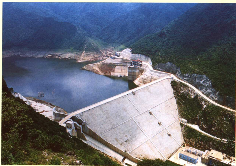
大二型柴石滩水库，坝高 101.8 米，库容量 4.37 亿立方米，完善配套灌溉工程后，可新增、改善灌溉面积 20.64 万亩。
