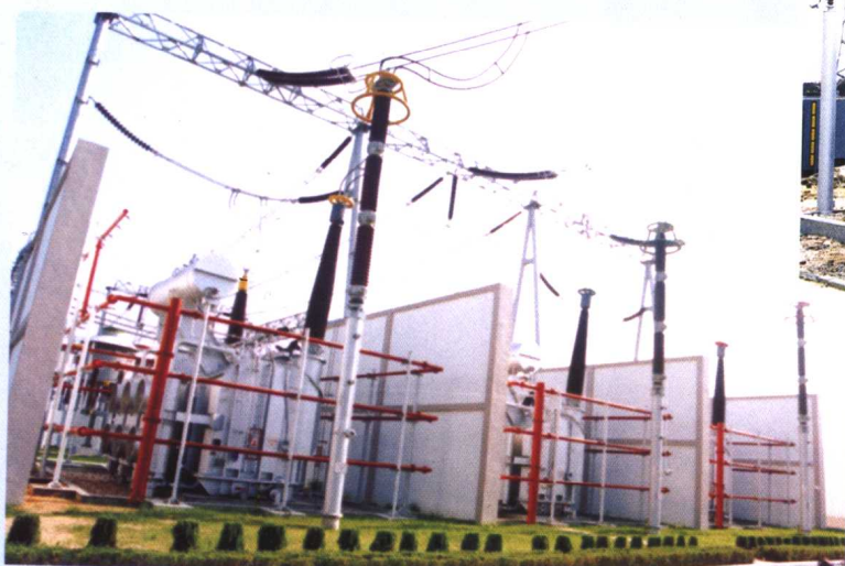
安装于聊城变电站的 ODFPS-250000/500 电力变压器
