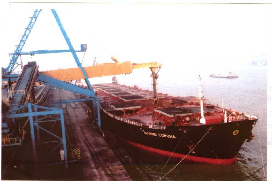
▲ 天津港南疆港区煤炭码头
