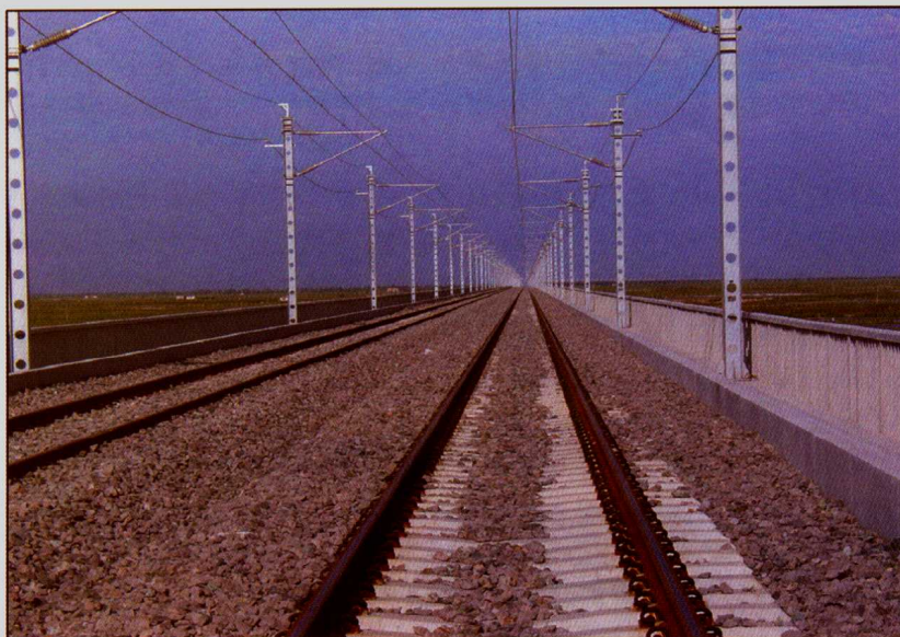
图 1—1—1 秦沈客运专线箱梁与轨道工程
