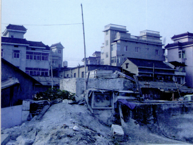
图 1.4 凌乱衰败的城市滨水区
