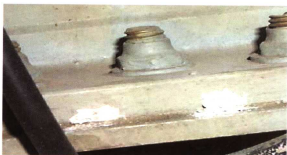
附图7 ××飞机中央翼1号大梁严重剥蚀
