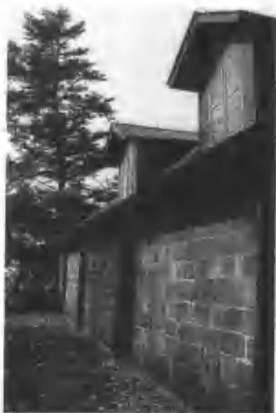
161 号的二楼凉台
