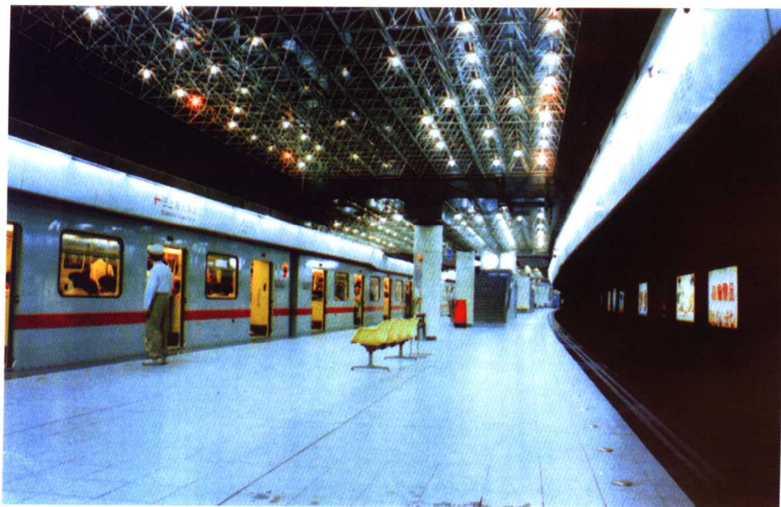
上海漕宝路车站站台层:采用金属网格吊顶,搪瓷钢板包柱
