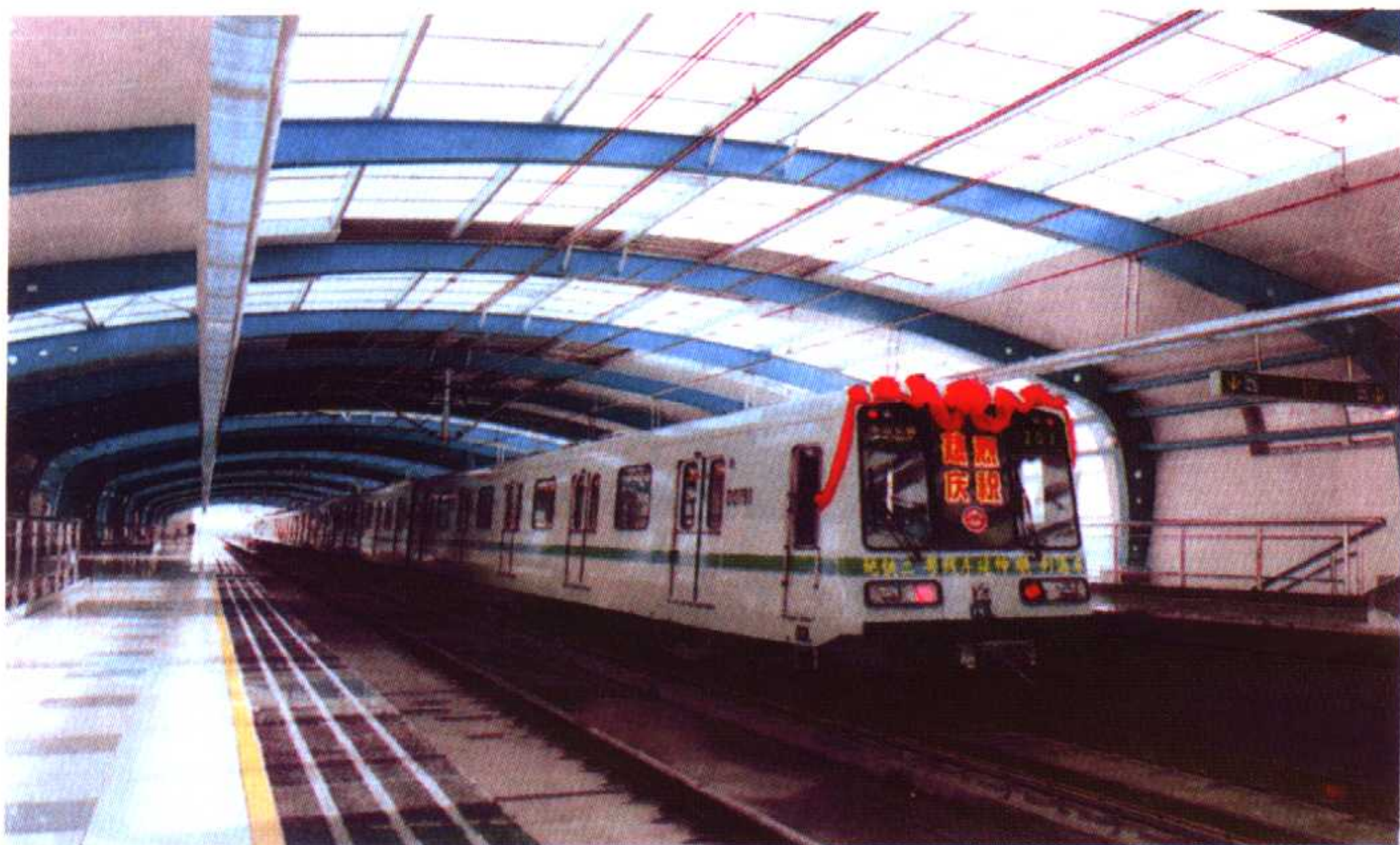
上海张江高科技站高架车站站台层： 钢单拱全封雨篷、阳光板与彩钢板相间屋面形成天然采光
