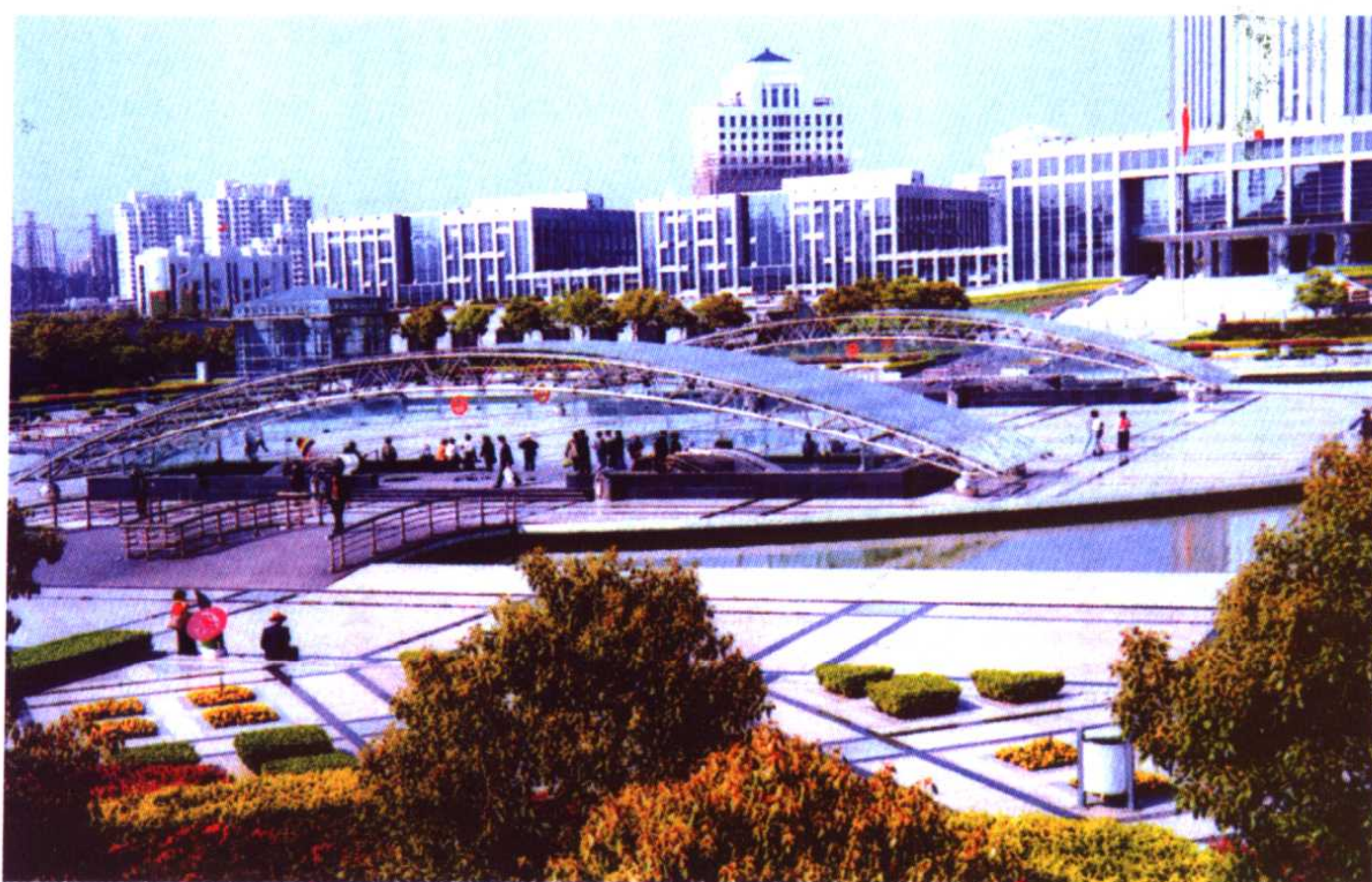
上海杨高路车站地面出入口:二组四个出入口,位于水景所围陆岛上,玻璃屋面、玻璃挂墙
