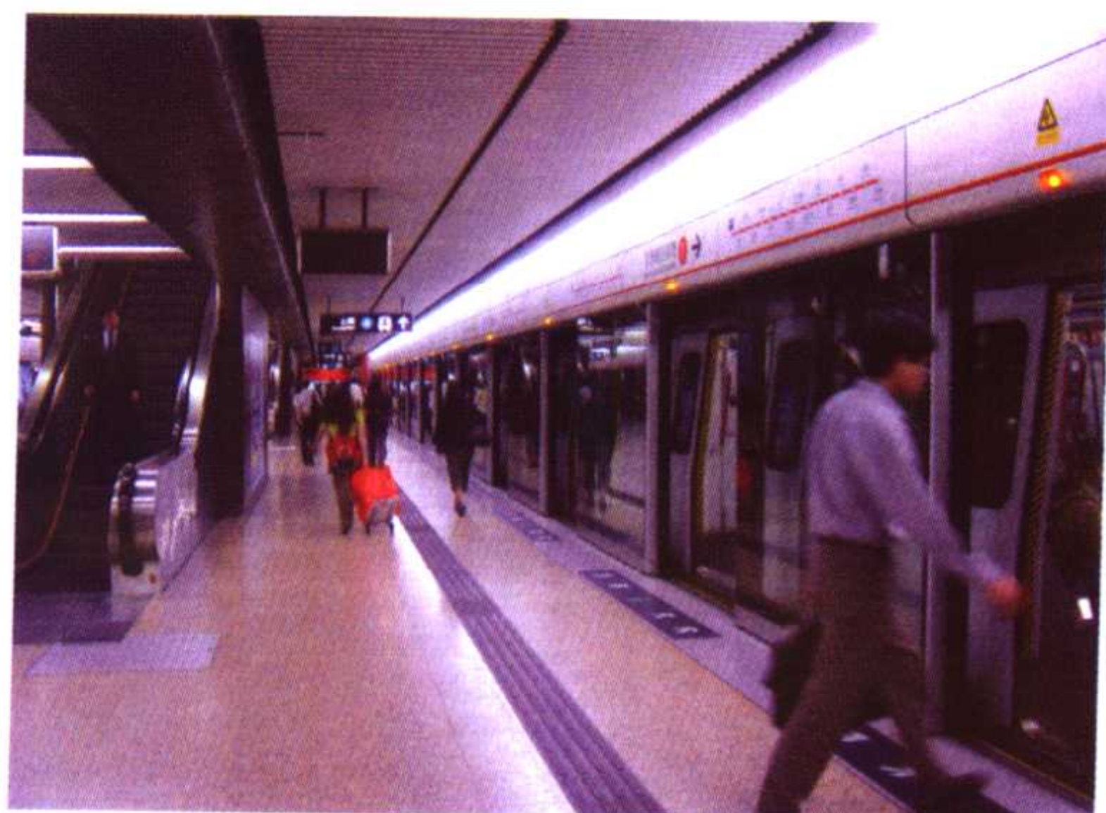
香港地铁新加装屏蔽门的站台层
