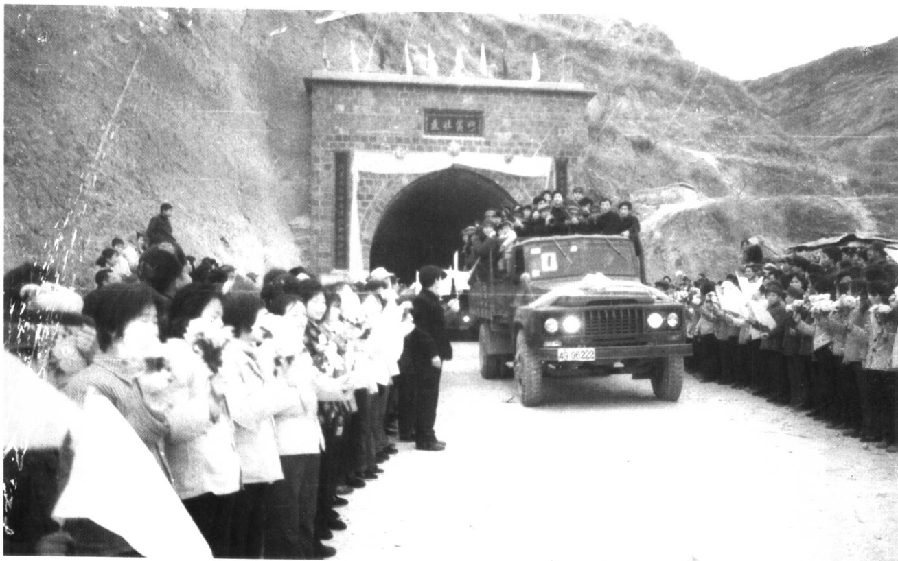
▲ 小寨村穿山隧道
