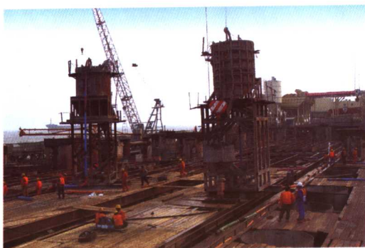
图 47 钢吊箱承台封底
