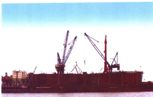
图 38 钢吊箱壁板合龙
