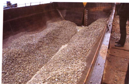
图 25 南主墩河床抛级配石料防护
