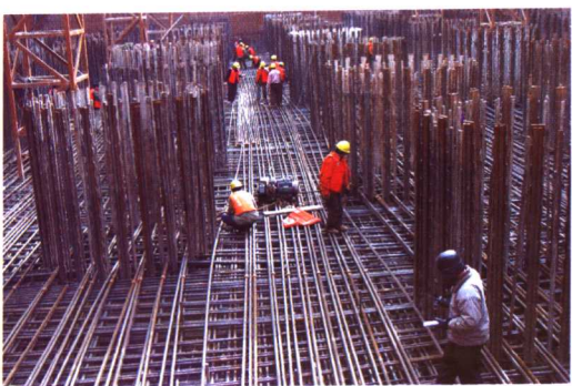
图 50 南主墩承台底层钢筋绑扎
