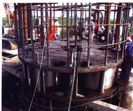
图 4 自平衡仪的安装
