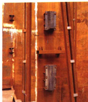
图 37 钢吊箱导向系统
