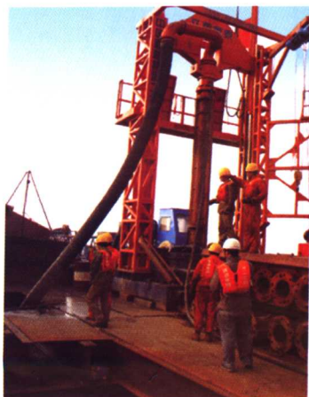
图 8 沉桩机下沉钢护筒
