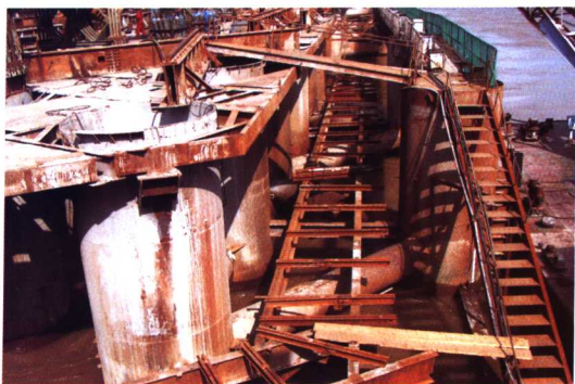
图 28 南主墩河床壁板拼装平台
