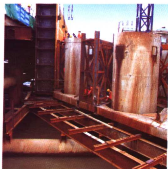
图 34 钢吊箱壁板拼装抗风稳定内靠架
