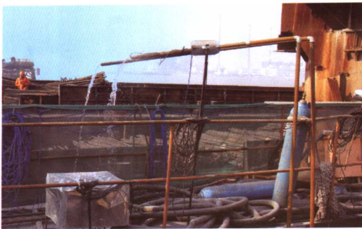
图 59 南主墩承台冷却管通水冷却
