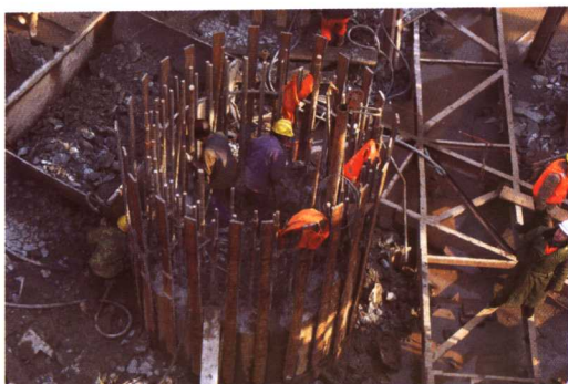
图 49 南主墩承台桩基破桩头
