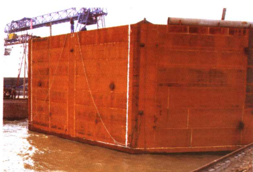
图 17 钢吊箱滑道下水
