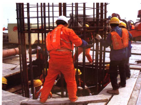
图 11 钢筋笼的接长
