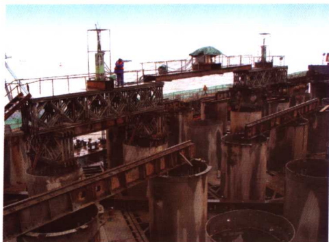
图 29 南主墩河床底板下放
