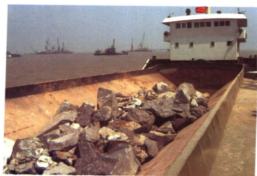
图 26 南主墩河床抛投块石防护
