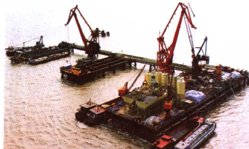
图 15 南主桥6~8号钻孔平台俯视图
