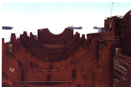
图 6 钢筋笼长线胎膜
