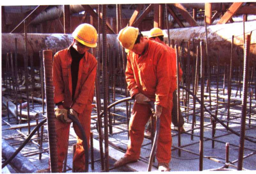
图 55 南主墩承台第二层混凝土振捣
