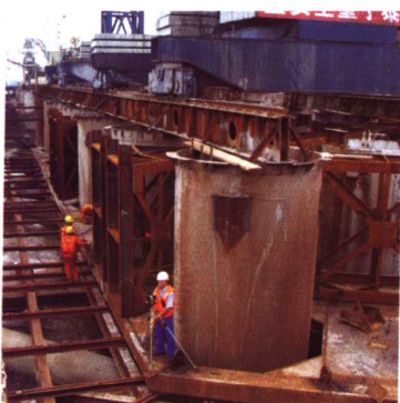
图 32 钢吊箱壁板拼装 GPS 精确定位
