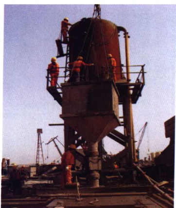
图 12 桩基混凝土的浇筑
