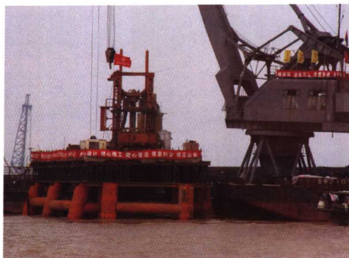
图 5 水中试桩平台
