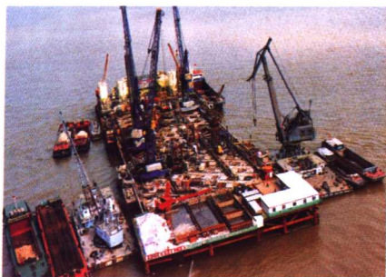
图 14 南塔主5号墩钻孔平台俯视图
