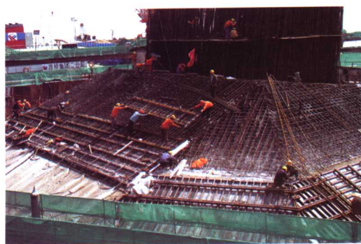
图 56 南主墩承台斜面压模
