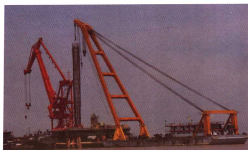
图 7 水中试桩钢筋笼的下放
