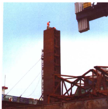
图 33 钢吊箱壁板拼装抗风稳定外拉缆位
