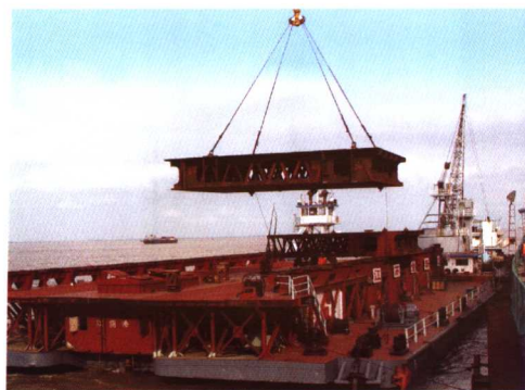
图 31 南主墩河床吊箱壁板驳运
