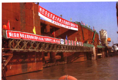
图 41 钢吊箱下放入水前
