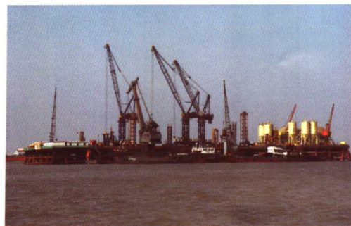
图 9 南塔主 5 号墩钻孔平台全景
