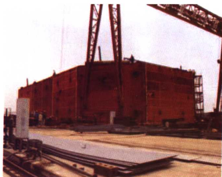
图 16 钢吊箱的整体加工
