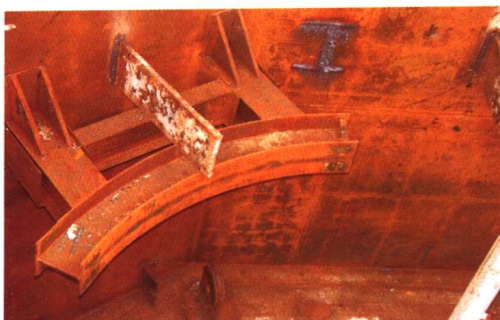
图 39 钢吊箱定位系统安装
