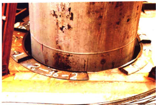
图 46 钢吊箱底板封堵钢板
