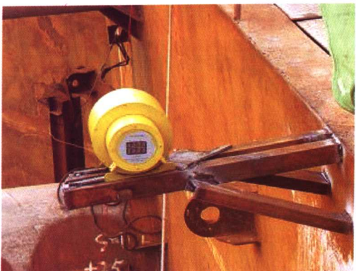
图 42 钢吊箱位移监控
