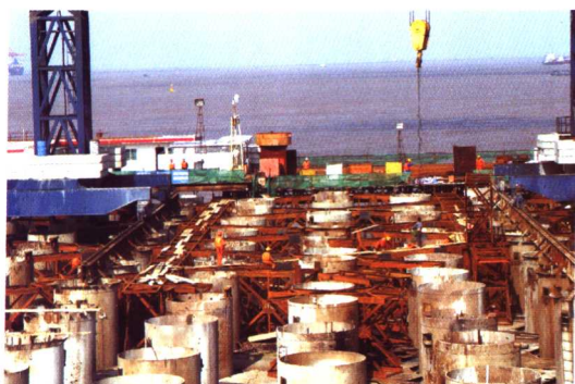
图 30 南主墩河床防撞桁架拼装
