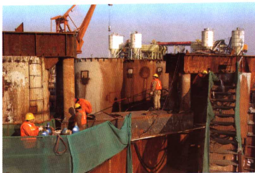
图 45 钢吊箱竖向定位系统安装
