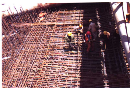
图 54 南主墩承台斜面钢筋绑扎
