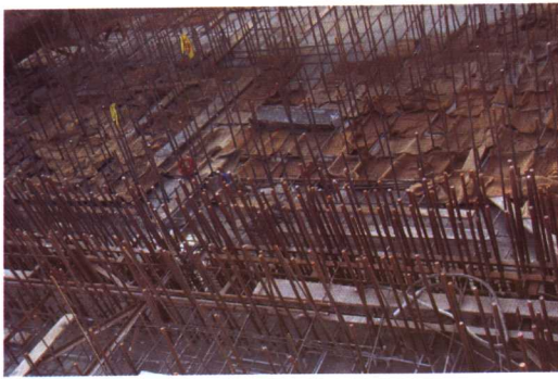
图 57 南主墩承台土工布保温养护
