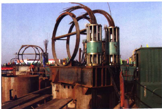
图 44 钢吊箱下放提升系统
