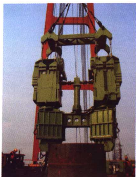
图 8 沉桩机下沉钢护筒
