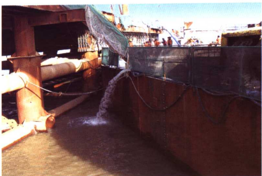
图 48 南主墩承台封底后吊箱内部抽水
