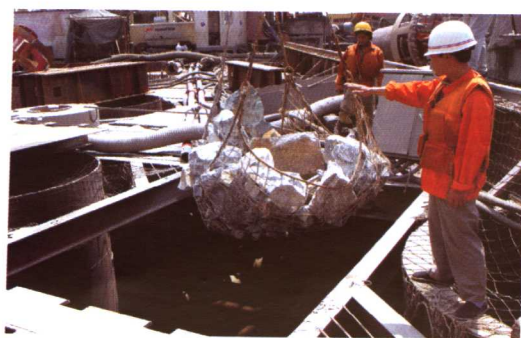
图 27 南主墩河床现场吊机定点抛投块石防护
