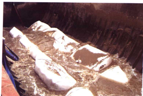
图 24 南主墩河床抛沙防护
