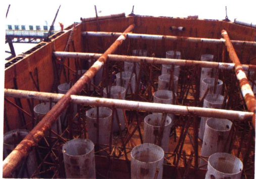
图 20 钢吊箱整体吊装就位
