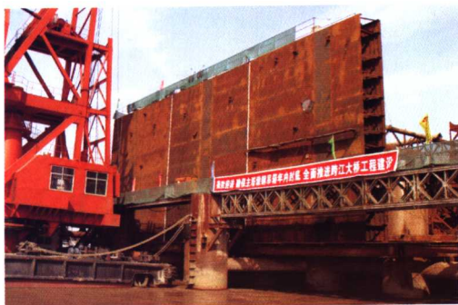
图 36 钢吊箱壁板拼装
