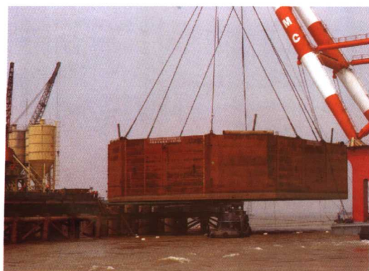
图 19 钢吊箱的整体吊装
