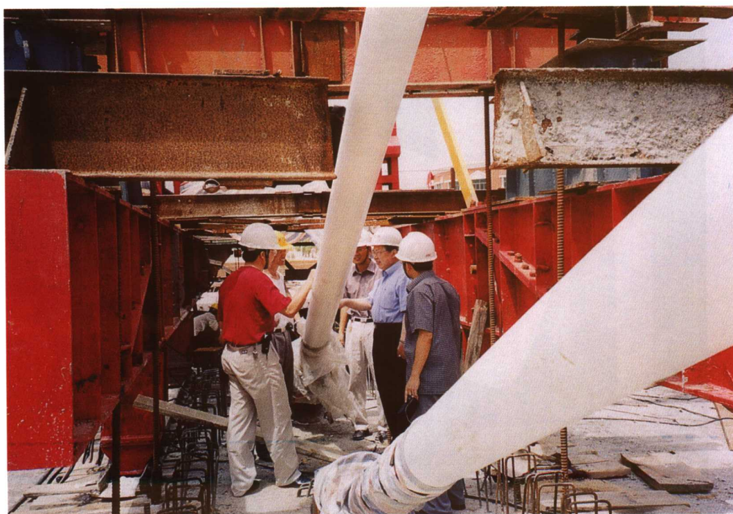
科研人员检查斜拉索安装质量
