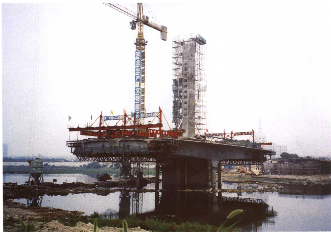
C_1, C'_1 斜拉索安装
