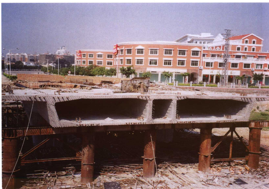
大桥主桥现浇段
