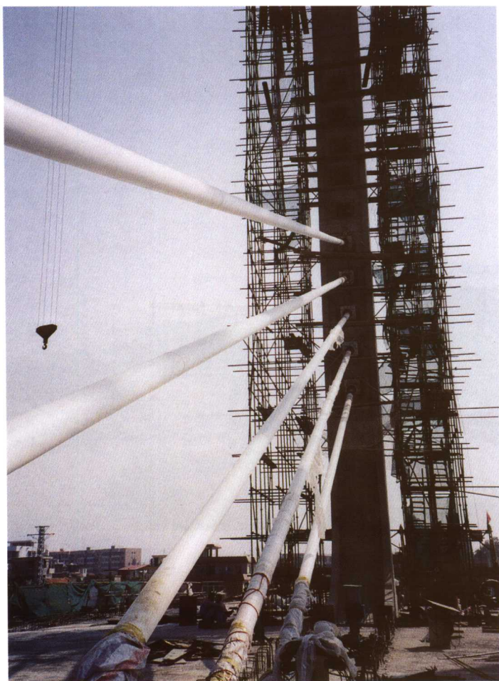
施工中的斜拉索
