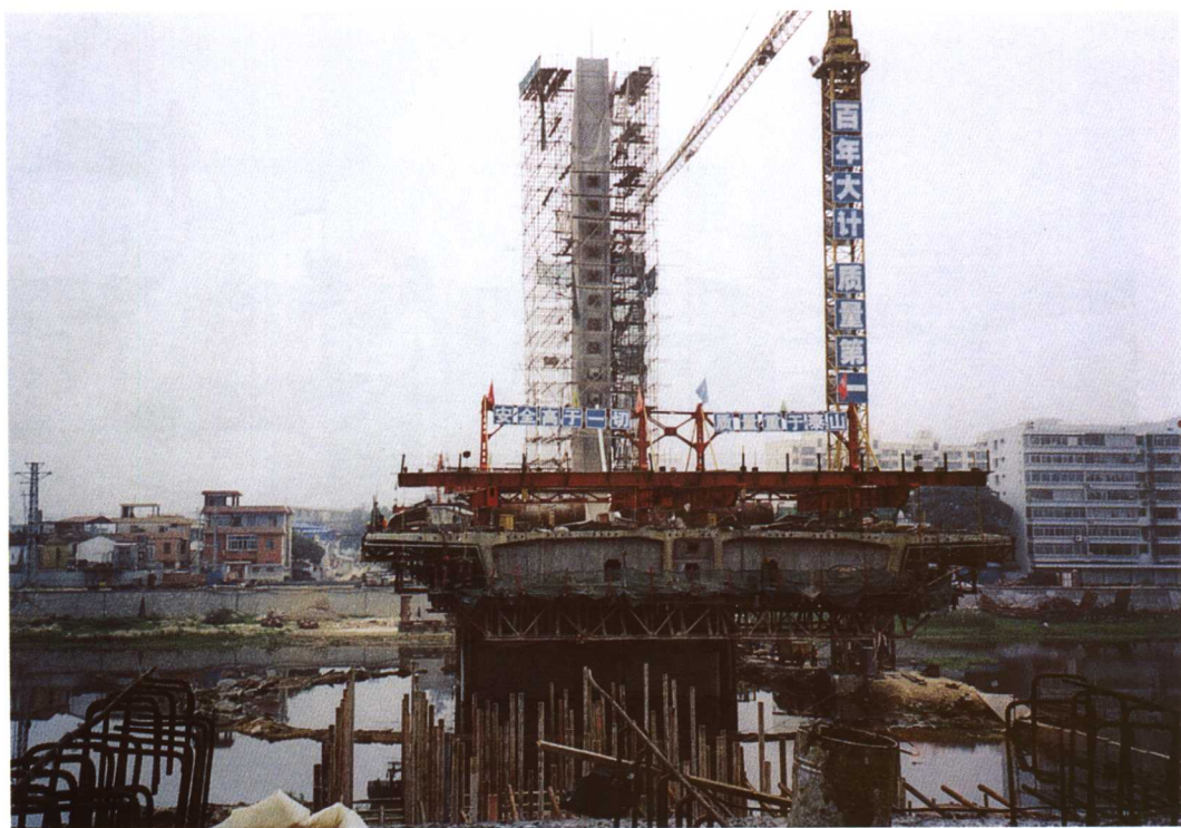
6号主梁悬臂施工
