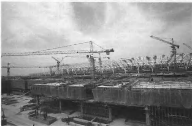
浦东国际机场交通中心施工景象
