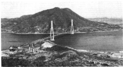
(a) 多多罗大桥
