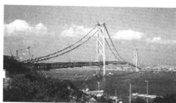
(a) 明石海峡大桥
