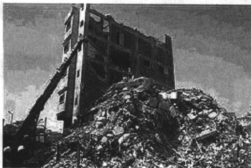
图 1.4 埃及亚历山大市纺织厂厂房在火灾中倒塌
