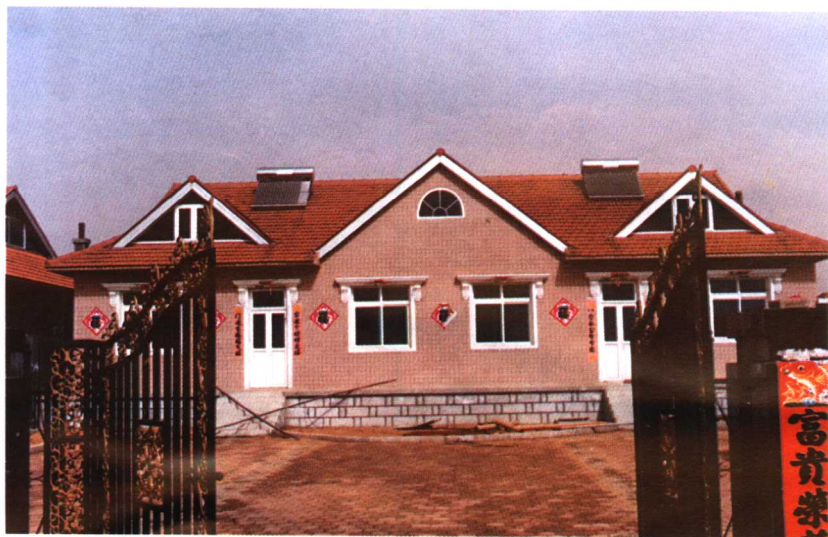
辽宁省大连市的被动式太阳房民宅，房顶为太阳能热水器
