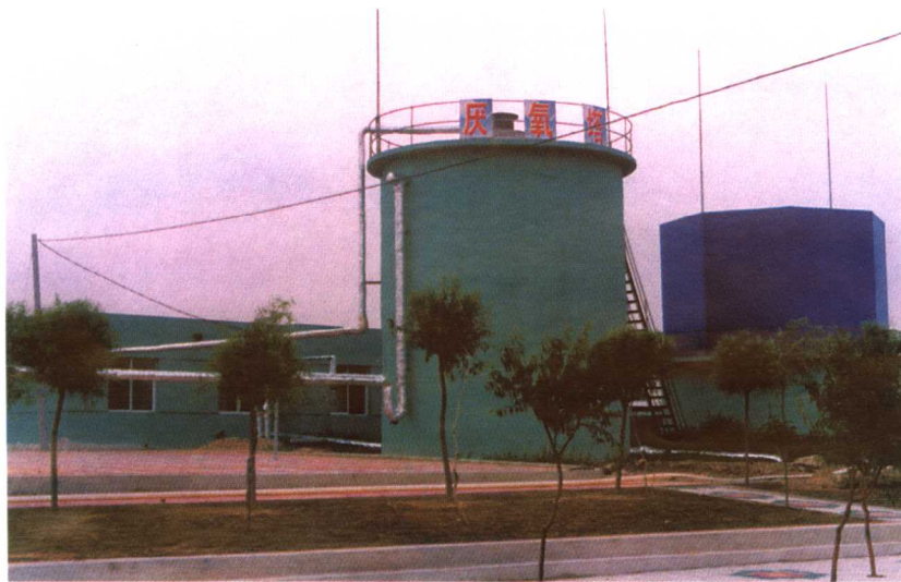
辽宁省阜新市的畜禽养殖能源环境示范工程（大中型沼气池）
