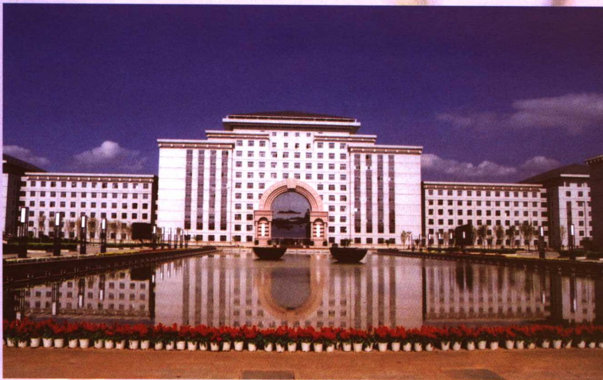
州政府办公大楼
