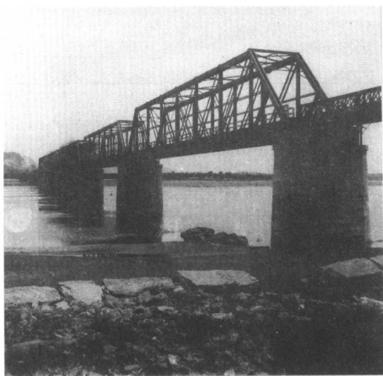
竣工后的滦河大桥
