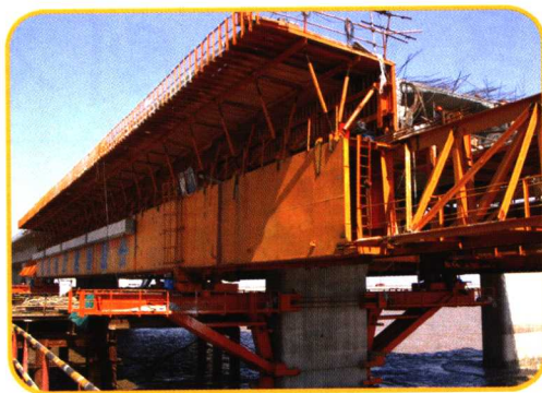
上海东海大桥
