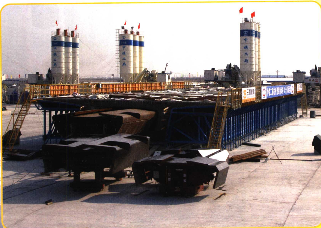
杭州湾跨海大桥——50M预制箱梁
