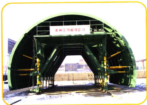
秦岭隧道全自动衬砌台车
