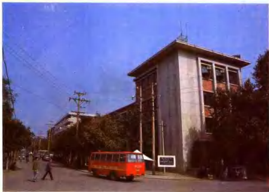
洛阳供电局营业楼
