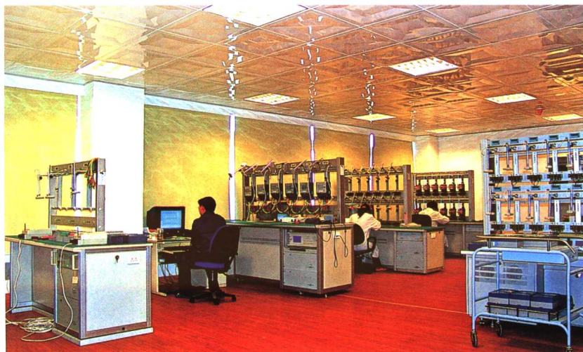
玉溪供电局计量中心
