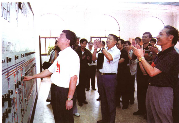
220 千伏江川变电站竣工投产，云南电力集团公司总经理朱志强（右）、王庆升（中）等领导参加了竣工仪式，中共玉溪市委书记杨崇勇（左）合闸通电（1998.8）
