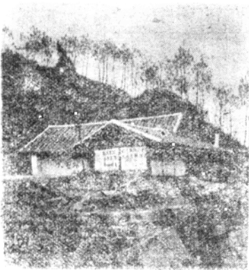
图10 重庆郊区金铜坡水电站 水头6公尺，流量0.3公方/秒，20瓩。
