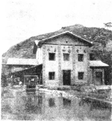
图7 福建省永春县卿园水电站 水头6公尺，流量1公方/秒，40瓩。
