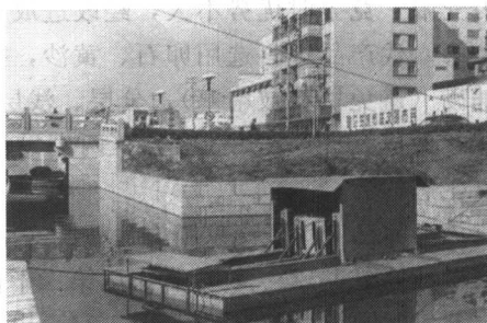
图 1-6 浮动生物滤清器在苏州干将河应用
