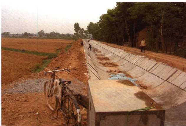
正在修建的渠道
