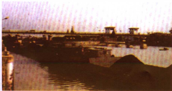
◀ 淮安水利枢纽工程，1972年12月动工，1980年完工，配有电机10台，装机总量16400千瓦，设计流量180立方米/秒，工程总投资3236万元，由中国人民建设银行淮阴地区中心支行提供一条龙金融服务
