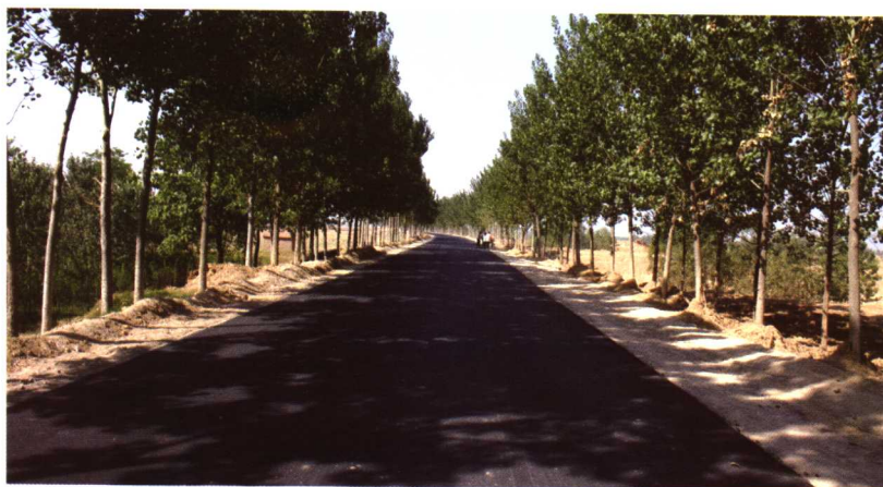
新修建的堤防道路成为抢险交通线
