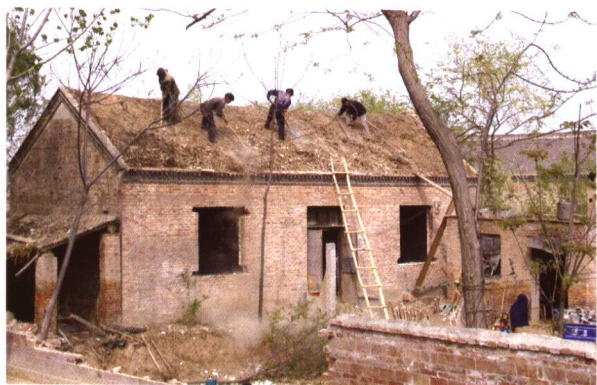
东明沿黄群众 拆迁房屋，支 持标准化堤防建 设
