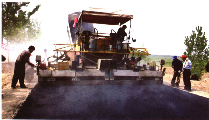
堤防道路施工
