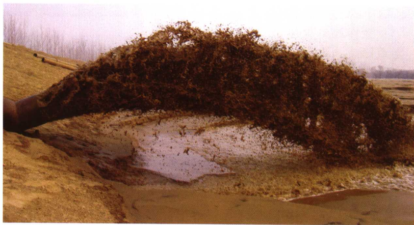
三千余万立方 米泥沙通过管道从黄 河内搬上大堤
