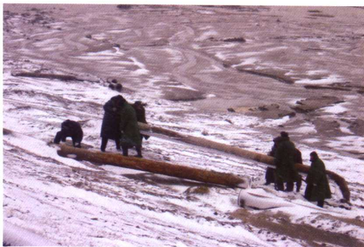
克服重重困难， 冬季冒冰雪坚持施工
