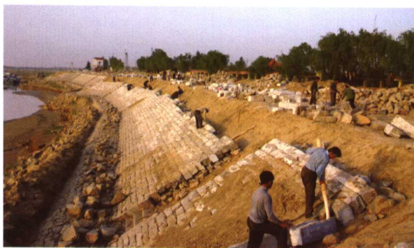
险工改建施工现 场
