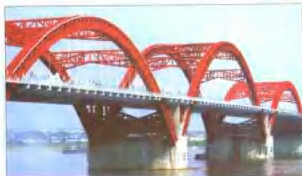
长沙市国道绕城高速公路 黑石铺特大桥
