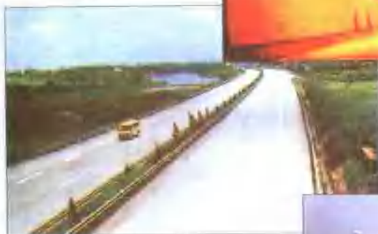
浏永高等级公路长沙县路段
