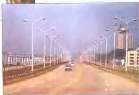
浏永高等级公路天马大桥东引桥
