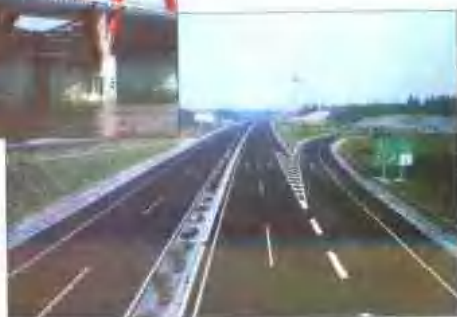
长沙市国道绕城高速公路西北段金霞互通
