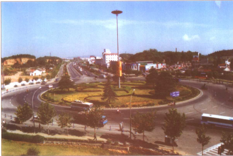
泰山新村广场
