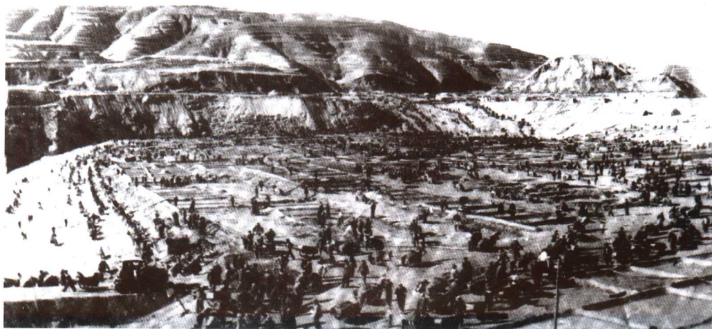
汾河水库大坝施工场景 (1958年)
