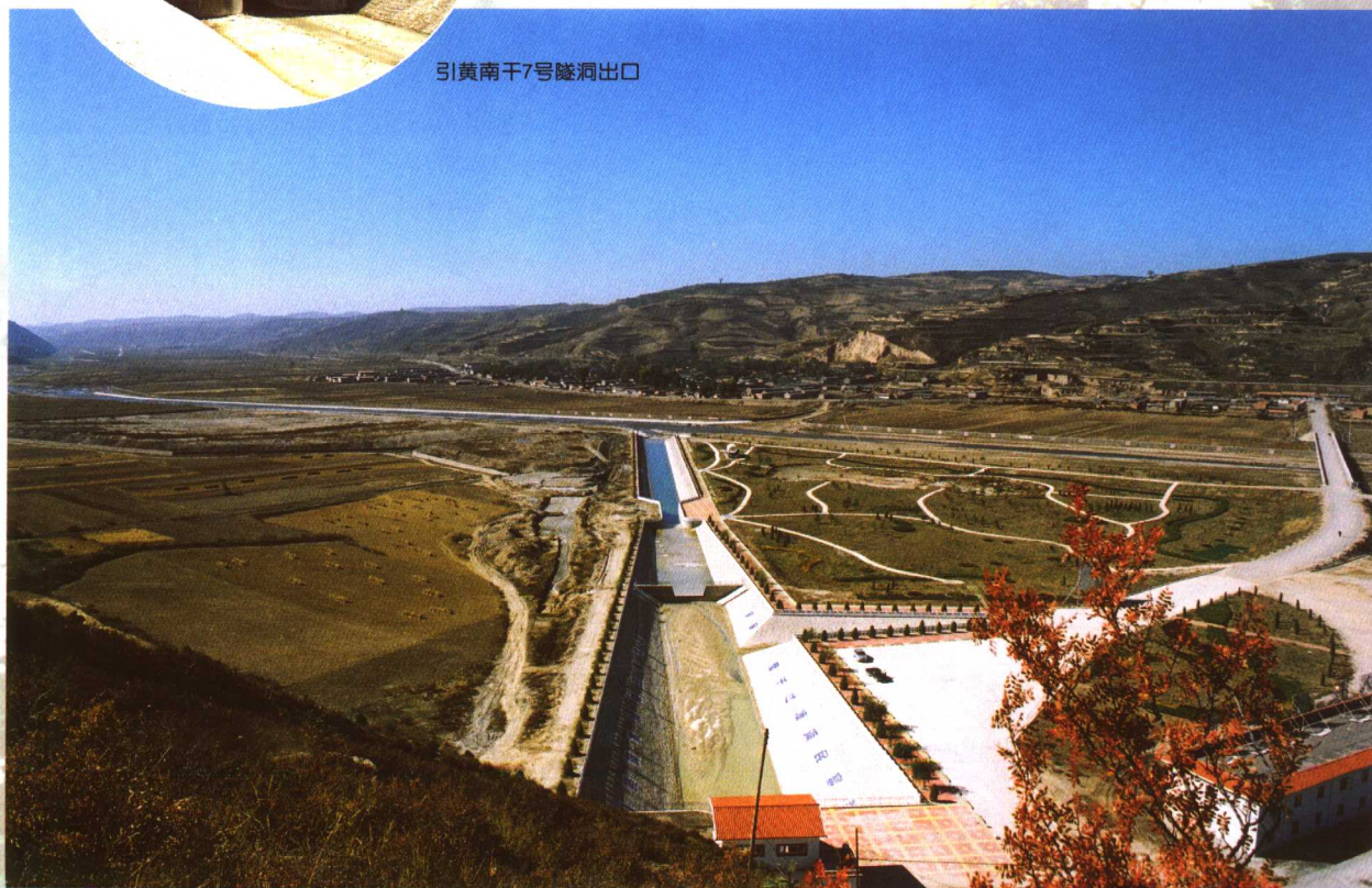
滚滚黄河水通过南干7号隧道进入引水干渠，在宁武县境头马营河段进入汾河上游干流河道。
