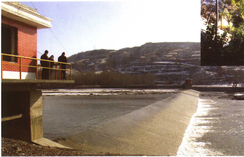
位于汾河上游静乐县境内的沙会滚水坝
