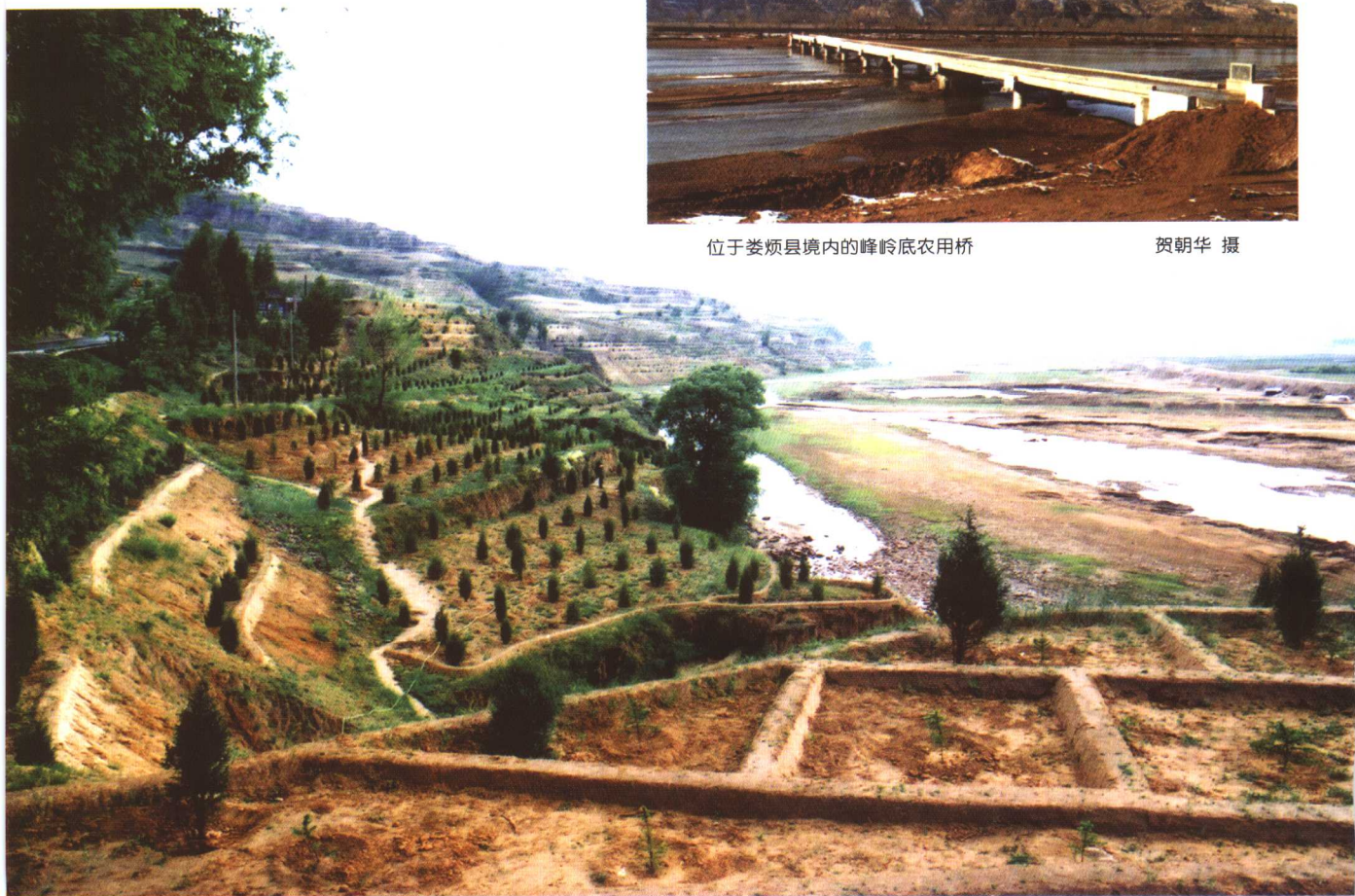
汾河上游静乐县一岸的水土保持工程
