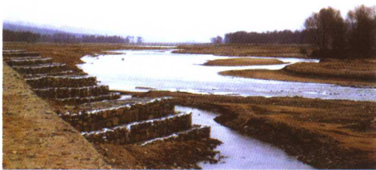
汾河上游河段的丁坝工程
