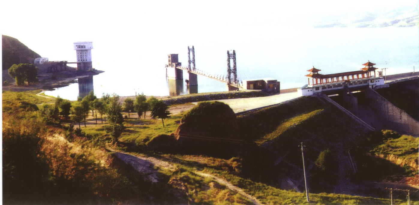
雄伟壮观的汾河水库枢纽工程。经过加固改建后的枢纽由拦河大坝、输水隧洞、泄洪排沙隧洞、溢洪道和水电站组成。
