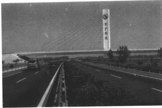
图 1-1 京沪高速公路实景图
