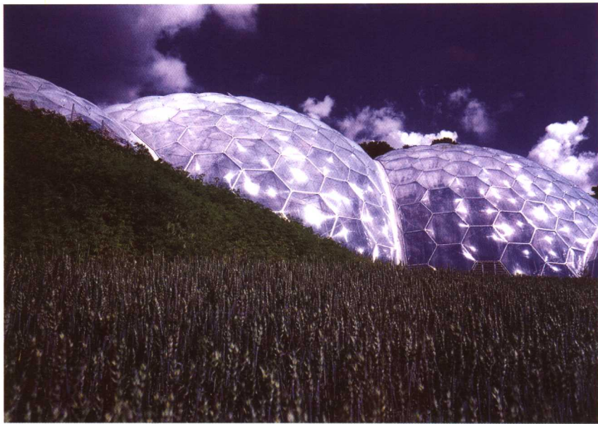
英国用于模仿各地气候的温室建筑 《The Eden Project》
