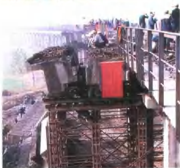
△6月，郑州桥隧段对京广线新乡唐庄特大桥进行换梁施工作业。
