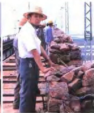
△分局长姚保国亲临郑州黄河大桥指挥防汛抛石作业。
