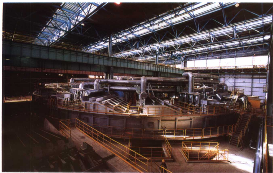
天津钢管公司 250 连轧管机组 的环形加热炉
